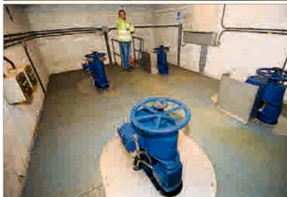
Compuertas del embalse abiertas (arriba), galería que recorre la presa, tubería que evacua la humedad y abajo los desagües de fondo. | J. ROLLER
