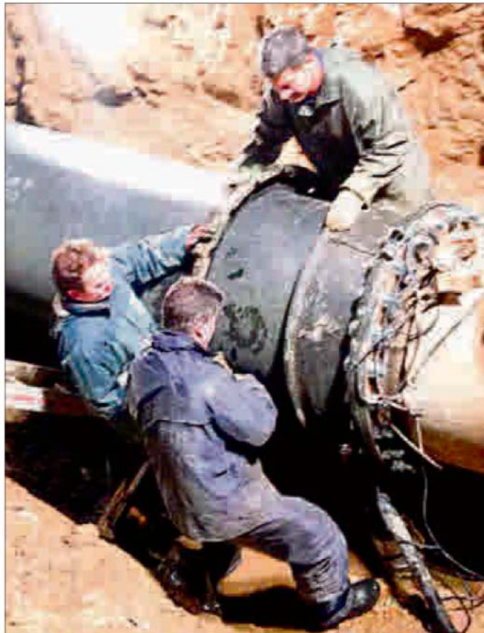
Emalcsa repara la conducción rota en 2014. | LA OPINIÓN
